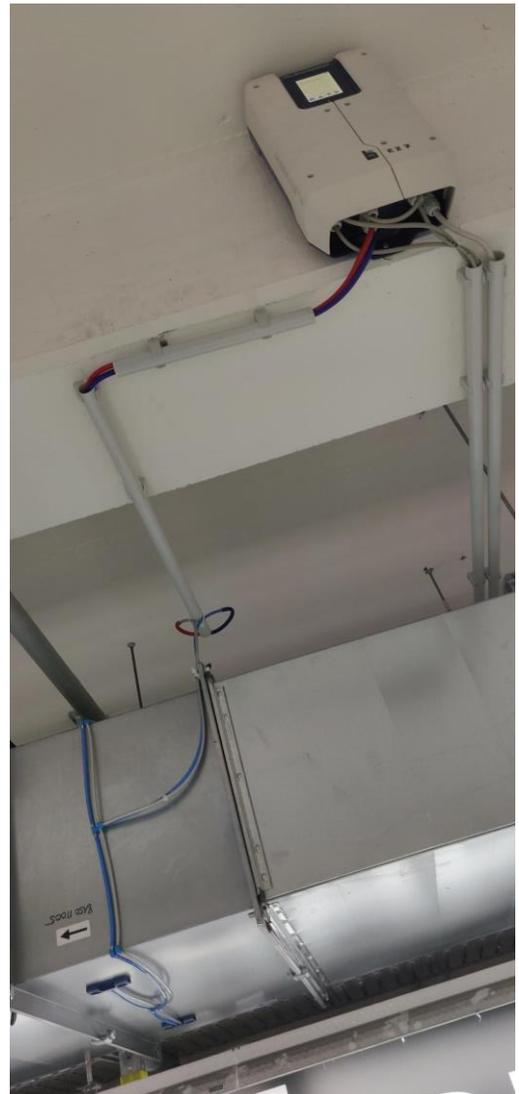
Die Zählerwerte, aber auch die kontinuierlichen Volumenstrom-, Temperatur- und Feuchtwerte werden über M-Bus ausgelesen und zu einem M-Bus-Master übertragen. Dieser leitet die Werte automatisiert an die Luftmeister-Cloud weiter, so dass der Eigentümer Aachener Grundvermögen ganz bequem die erforderlichen Abrechnungsparameter über eine monatliche E-Mail erhält. Abb. 6 zeigt, welche Werte dabei übertragen werden und wie dann auf Basis der VDI 2077-4 abgerechnet wird.
