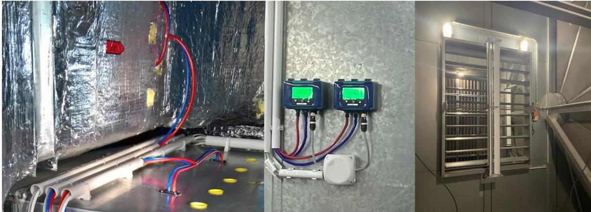
Einbau von je zwei Präzisionssonden „Luftmeister Kassel“ in Zuluft- und Außenluftkanal, mit symmetrischer Verschlauchung. Die gelben Kappen verschließen die Kalibrieröffnungen
